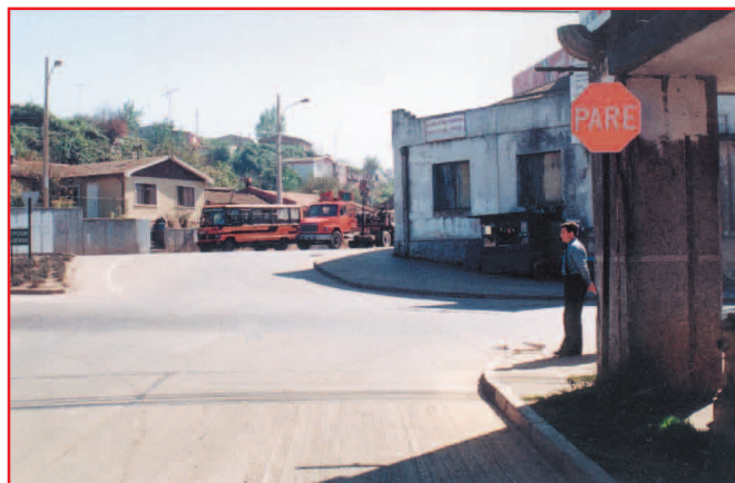
La visibilidad (hacia la izquierda) de esta vía menor es deficiente debido a ángulo y línea de edificación. Peatones tienden a cruzar en lugares de mayor riesgo (esquinas)
