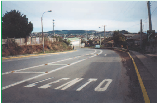
Mediana fantasma angosta la vía lo cual calma la velocidad. Se mejora notoriedad de la delineación de la vía con soleras amarillas y señales chevron
