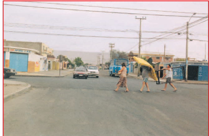
Intersección con múltiples conflictos por virajes hacia la izquierda. no existen facilidades seguras para el cruce de peatones
