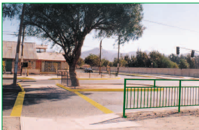
Se proveen circuitos claros para el cruce de peatones. Aquí se habilita espacio en la mediana. Vallas canalizan movimientos
