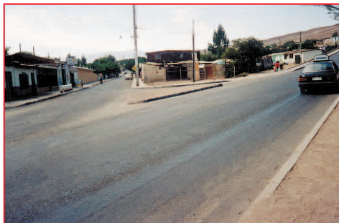
Vía principal con exceso de velocidad debido a que es una vía larga, recta y en pendiente. Virajes hacia la izquierda riesgosos (hacia vía a la izquierda)
