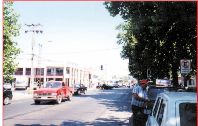
En esta intersección se producen conflictos entre los diferentes movimientos vehiculares debido a que falta canalización y notoriedad de la intersección. Peatones no tienen espacios bien definidos para cruzar, además deben cruzar cuatro pistas.
