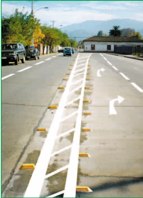
Mediana fantasma angosta la vía calmando la velocidad, y canaliza el tráfico hacia la intersección con la vía menor lo cual hace que el conductor perciba con mayor claridad los cambios a enfrentar. Peatones pueden cruzar en etapas.
