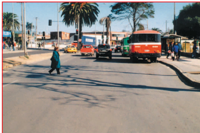
En esta vía falta canalización de los movimientos vehiculares y de elementos seguros para cruce de peatones. Peatones tienden a cruzar indiscriminadamente asistidos por la mediana
