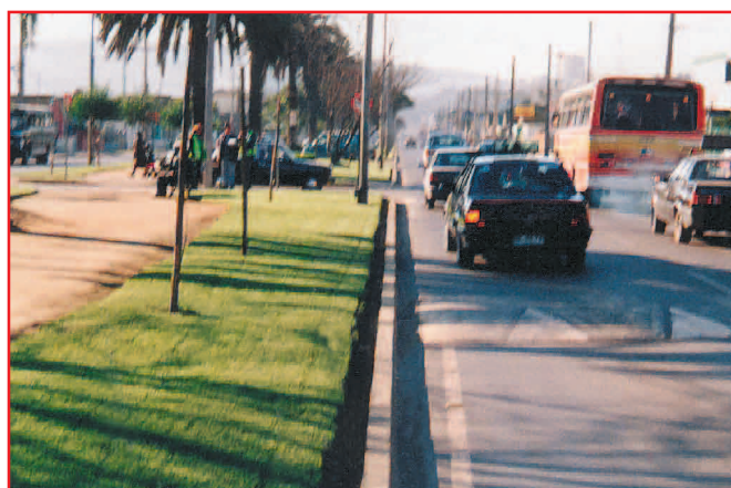
Senda peatonal en la mediana pierde continuidad debido a la falta de facilidades para el cruce de peatones
