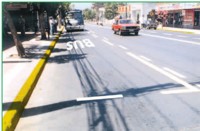
Demarcaciones de eje, pista y de paradas, incentivan mejor comportamiento de conductores
