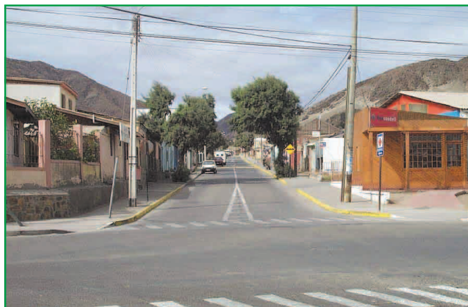
Tratamiento calmante de velocidad; lomos de toro, y mediana que se abre en las intersecciones.
