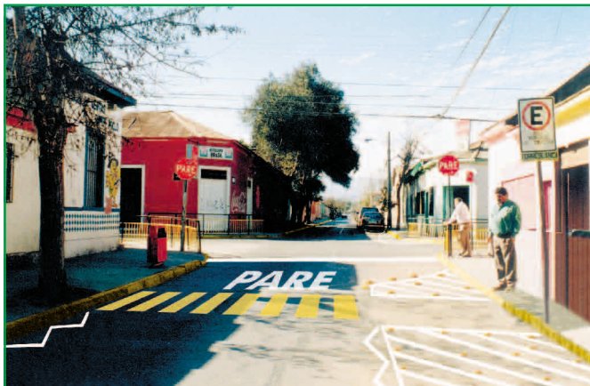
Extensiones de aceras mejoran la visibilidad de los vehículos de la vía menor, y permite cruce de peatones en lugares despejados y retirados de las esquinas para evitar conflictos con vehículos que esperan o viran
