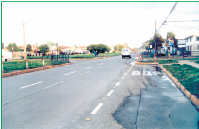
Extensión de acera impide detenciones y estacionamiento hasta la esquina, mejorando visibilidad de vehículos y de peatones; también ayuda a calmar la velocidad puesto que angosta la vía. Condiciones de seguridad de los peatones mejoran ya que ven mejor y son mejor vistos y se reduce distancia de cruce
