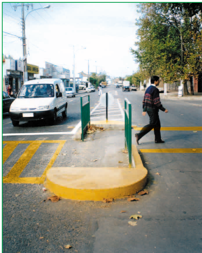
Islas peatonales permiten cruce en dos etapas, y además en forma escalonada dando mayor seguridad a los peatones
