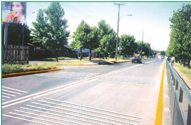
Bandas alertadoras, demarcación doble del eje, y soleras amarillas, alertan al conductor que las condiciones en el sector son diferentes. Vallas canalizan a peatones hacia lugares más seguros para cruzar o para abordar buses
