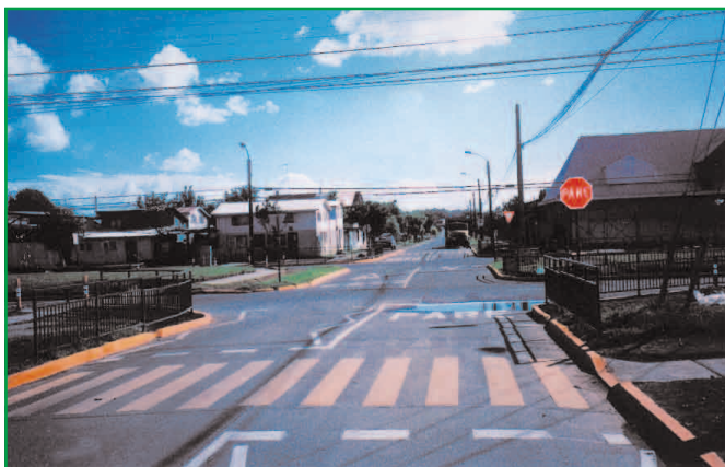
Se proveen las demarcaciones requeridas, y cruces peatonales que están desplazados de la esquina para evitar conflictos con vehículos que viran o esperan. Vallas canalizan peatones. Nótese habilitación de senda peatonal en mediana de vía principal
