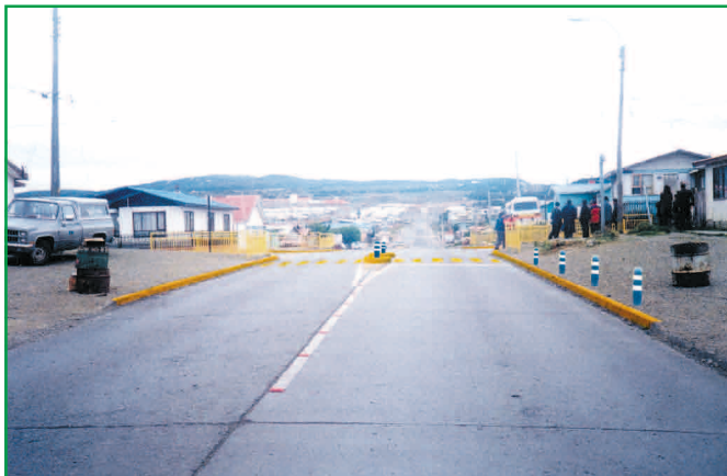
Soleras amarillas, islas medianas fantasmas, islas peatonales, topes y vallas, todos contribuyen a mejorar la notoriedad de la intersección, además de sus funciones propias
