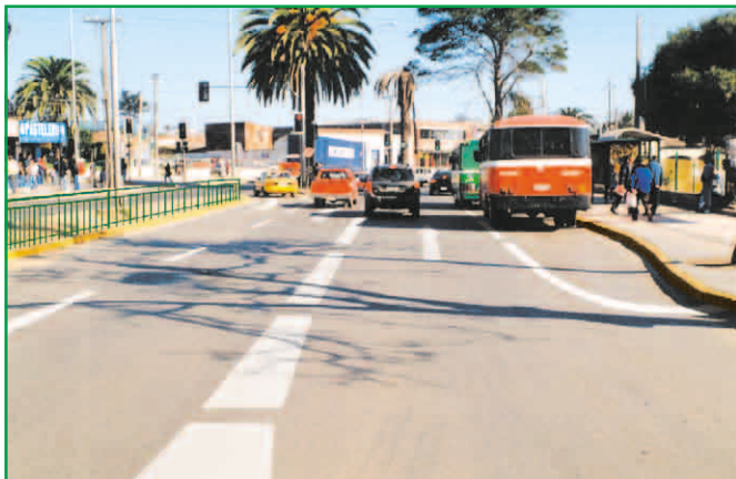
Demarcaciones definen espacios de circulación y detención. Vallas impiden cruce de peatones en lugares riesgosos
