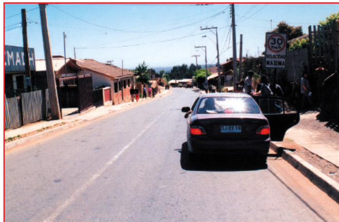
Tramo largo, rector y en pendiente, incentiva la velocidad. No existen condiciones seguras para el cruce de escolares del colegio (derecha). Vehículos que se estacionan a la entrada del colegio entorpecen visibilidad de los peatones.
