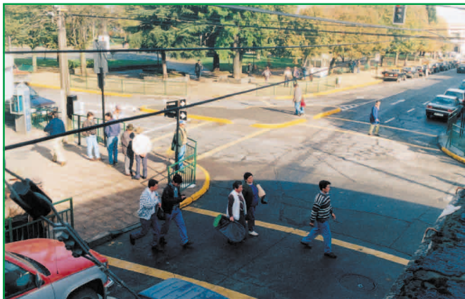
Islas canalizadoras en todas las esquinas de la plaza permiten que peatones puedan cruzar en dos etapas, además de canalizar los movimientos vehiculares
