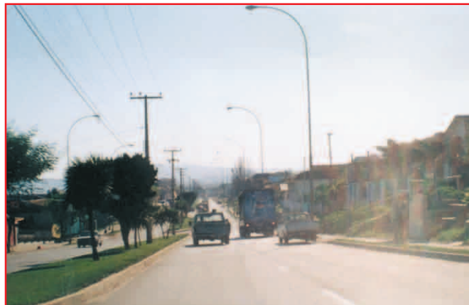
Vía de acceso a la ciudad con pendiente, larga, recta y ancha, incentivan velocidades inapropiadas. También falta notoriedad a intersección que está justo en cima.
