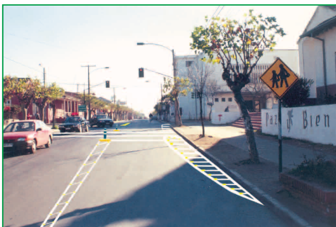
Islas canalizan movimientos definiendo más claramente el cambio de operación de la vía ( de dos a un sentido). Peatones pueden cruzar en dos etapas asistidos por islas peatonales
