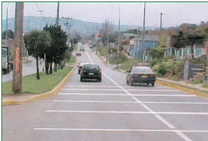
Demarcaciones transversales calman la velocidad puesto que los conductores perciben que van a mayor velocidad que la real. También permite que la intersección adquiera mayor notoriedad.
