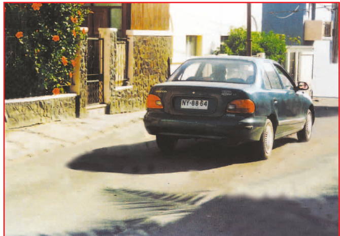
Este pasaje es usado por vehículos de carga, como atajo entre dos vías principales creando situaciones de riesgo para sus residentes.
