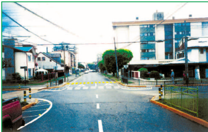
Extensiones fantasmas de aceras mejoran visibilidad de vehículos y peatones. Nótese cruce peatonal desplazado de línea de detención para reducir conflictos entre peatones y vehículos. Vallas canalizan peatones. Extensiones, topes, vallas y soleras amarillas mejoran notoriedad de la intersección
