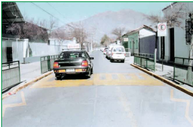
Se instalan lomos de Toro planos con cruce cebra para calmar la velocidad. Las vallas canalizan peatones y también desincentivan el estacionamiento y detención de vehículos
