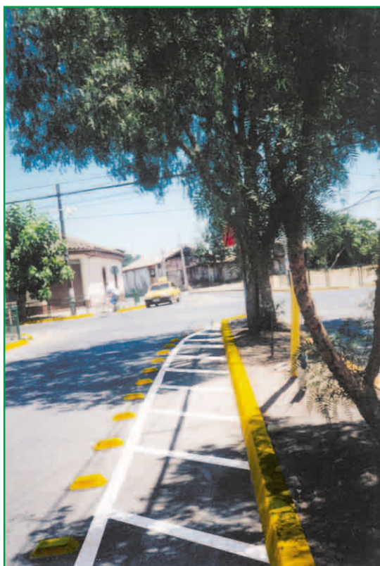
Se ensancha mediana (en forma fantasma con demarcaciones) para que los peatones que cruzan puedan tener mejor visibilidad ya que está obstruida por los árboles
