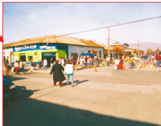
No existen facilidades seguras para el cruce peatonal en esta intersección con altos flujos peatonales debido a existencia de feria
