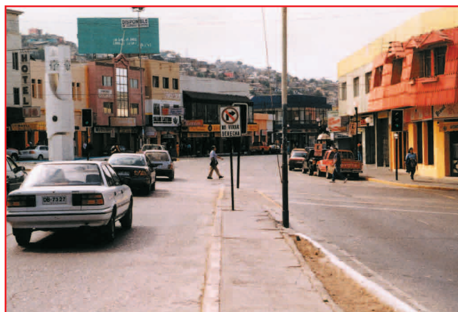
En este tramo se juntan los flujos de dos vías convergentes, produciéndose múltiples entrecruzamientos. Peadones no cuentan con facilidades seguras para cruzar
