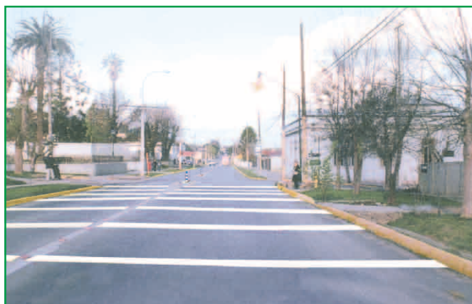
Se mejora la notoriedad de las intersecciones con las demarcaciones transversales previo a éstas, eje que se abre, e islas peatonales; estas últimas ayudan a que peatones crucen en dos etapas
