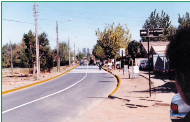
Bandas alertadoras calman la velocidad al alertar al conductor que las condiciones son diferentes. Entorno es más seguro para los peatones.
