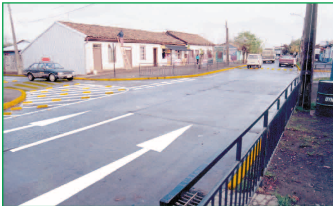
Movimientos vehiculares de la vía menor, son canalizados (con extensiones fantasma de aceras) para que empalmen más directo con la otra sección de la vía. Peatones son canalizados con vallas
