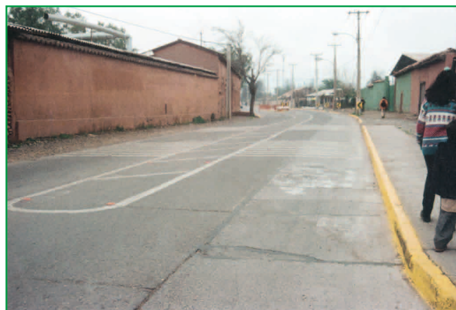
Mediana fantasma y bandas alertadoras calman la velocidad antes de enfrentar el tramo de la curva con la intersección.
