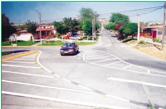
Demarcaciones definen el espacio: la continuidad de las vías y las prioridades. Los conductores ahora perciben claramente como funciona esta intersección
