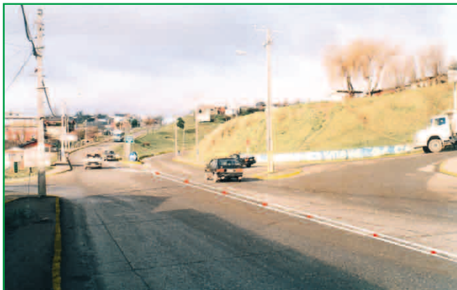
Demarcaciones aclaran dudas al conductor ya que definen claramente la operación de las vías.
