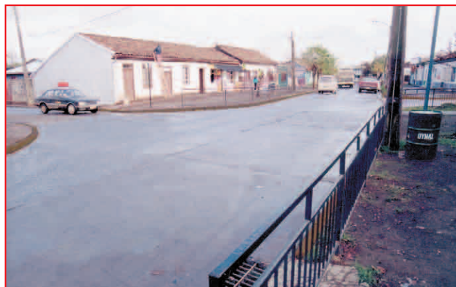
En esta intersección, la vía menor es escalonada por lo cual no se percibe su continuidad. Esto genera reacciones confusas e imprevistas por parte de los conductores. Tampoco existen facilidades seguras para el cruce de peatones
