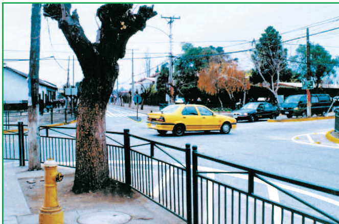
Extensiones fantasma de acera angostan la vía principal calmando la velocidad, y mejoran también la visibilidad para vehículos de la vía menor. Peatones son canalizados con vallas a lugares de menor riesgo
