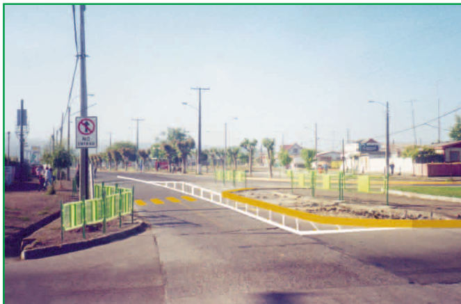
Se cierra una pista y la otra se angosta al mínimo para impedir que se use como atajo
