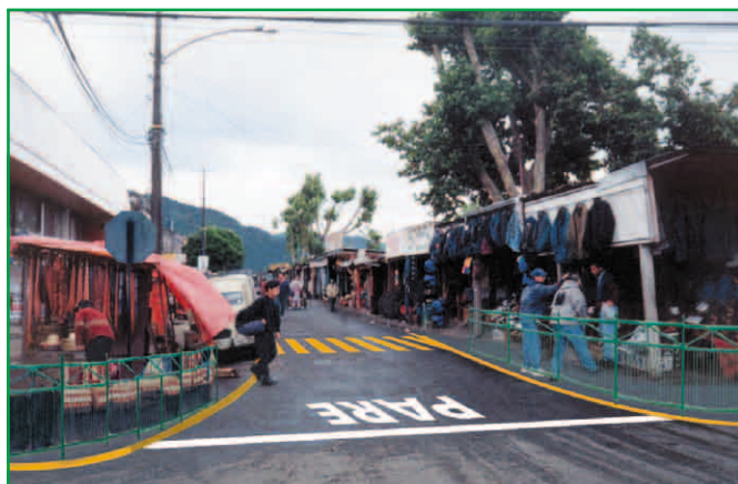
Extensiones de aceras y franja extra de calzada asignada a peatones. Vallas para canalizar. Nótese cruce desplazado hacia atrás de línea de detención
