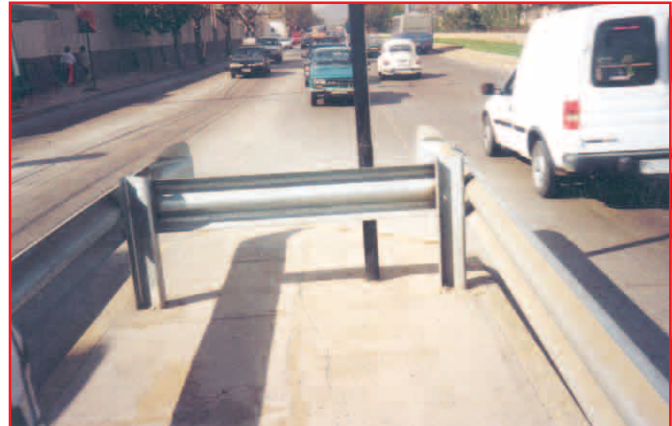
Esta es una intersección "T" (vía menor está hacia la derecha) en donde se producen conflictos debido principalmente, a la falta de canalización de los movimientos vehiculares, especialmente los virajes hacia la izquierda a vía menor
