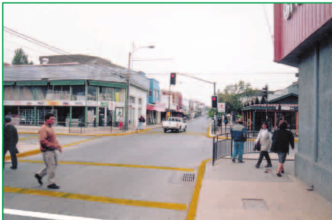
Un tratamiento básico: demarcaciones definen espacios de los usuarios . Vallas canalizan a peatones
