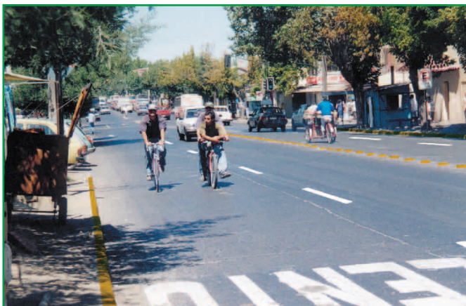
Tratamiento mínimo con tachones para el eje que es doble, demarcaciones pistas y provisión de vallas peatonales en sitios de mayor riesgo
