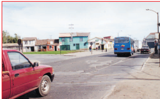
En este tramo de vía existen muchos entrecruzamientos ya que los conductores no cuentan con elementos que los orienten. Tampoco existen elementos para guiar a los peatones
