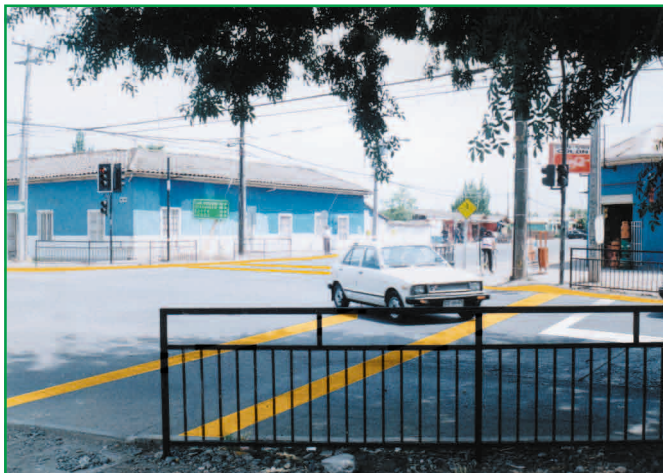
Se demarcan los pasos peatonales, líneas de detención de vehículos, soleras amarillas, lo cual define claramente los espacios. Se proveen vallas para canalizar a los peatones hacia los lugares de cruce
