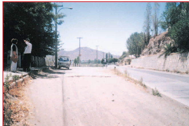
Esta área de descanso (mirador), es percibida por algunos conductores como un ensanchamiento de la vía, especialmente de noche. La baranda (izquierda) que se abre gradualmente contribuye a la errada percepción de la delineación de la vía
