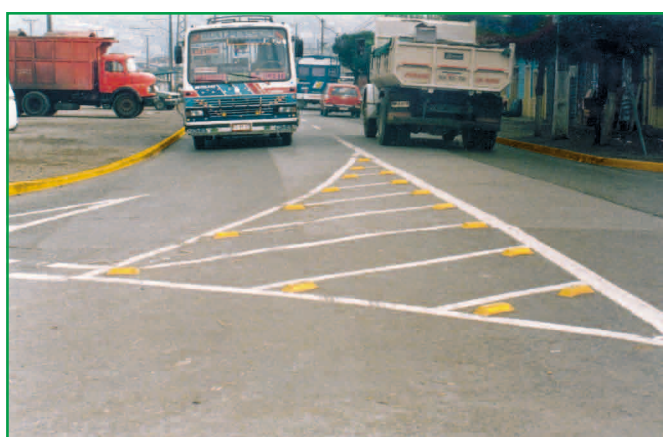
Otra de las vías menores que se intersectan con vía principal donde se han canalizado los movimientos. Peatones pueden cruzar en dos etapas
