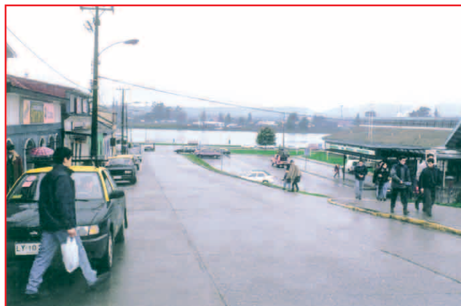
En este tramo existen muchos conflictos por los accesos vehiculares al terminal (a la derecha). No existen facilidades para el cruce seguro de peatones, tienden a cruzar en cualquier lugar
