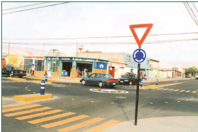
Mini-rotonda elimina conflictos por virajes hacia la izquierda. Peatones pueden ahora cruzar en dos etapas asistidos por islas peatonales.
