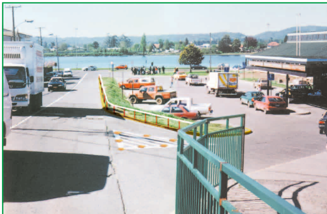
Se canalizan los movimientos vehiculares en los accesos al terminal. Peatones son canalizados con vallas y barreras hacia lugares más seguros.
