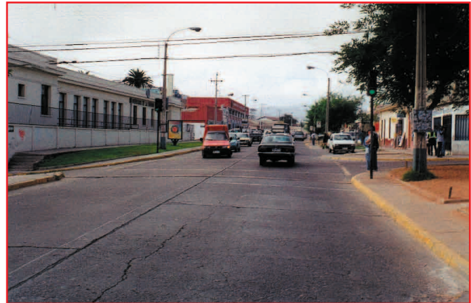
Vía larga, recta y de pistas anchas incentiva la velocidad. No existe un espacio protegido para los virajes hacia la izquierda en la intersección
