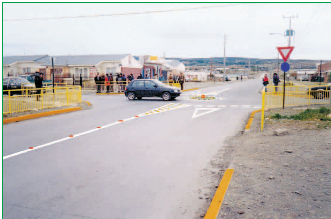
Mini-rotonda elimina conflictos por virajes hacia la izquierda, también calma las velocidades de vía principal, y soluciona los problemas de brechas de la vía menor. Vallas orientan cruce de peatones hacia lugares más seguros.
