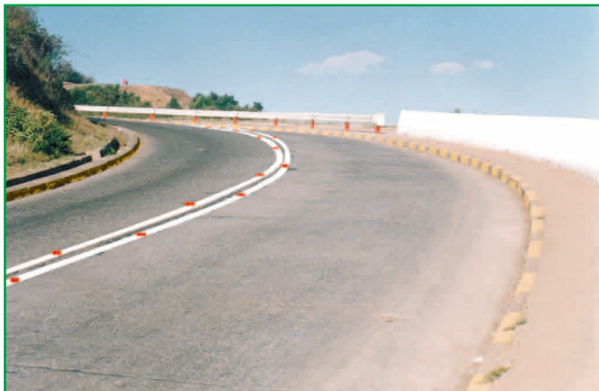
Soleras pintadas, barrera de contención, demarcación del eje resaltan la delineación de la vía, lo cual mejora comportamiento de conductores
