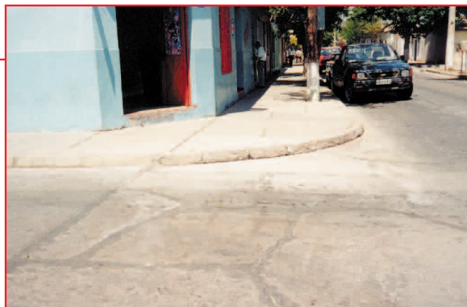
Postes, árboles y vehículos estacionados, entorpecen visibilidad de conductores de vía menor, y de los peatones que cruzan
