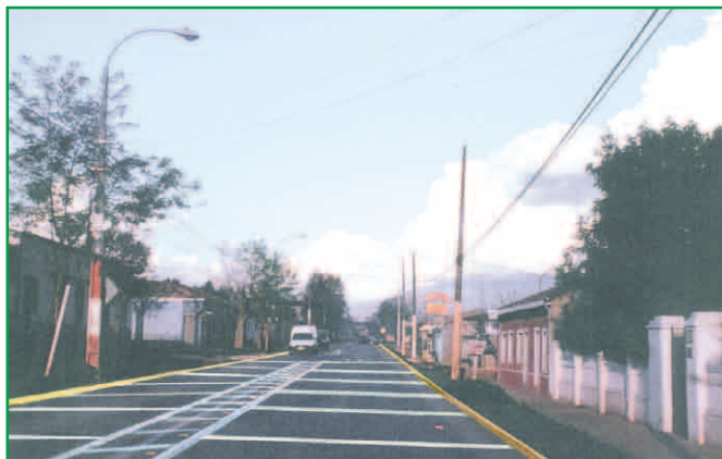
Demarcaciones transversales hacen percibir al conductor que va a mayor velocidad y por lo tanto tiene un efecto calmante de velocidad. La mediana angosta la vía y ayuda a calmar la velocidad; además, asiste a peatones a cruzar en dos etapas
