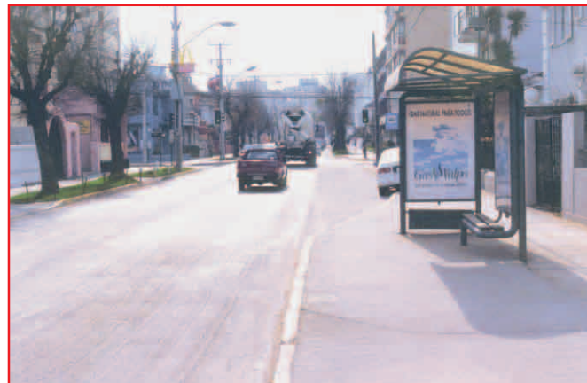
La bahía de parada de buses (derecha) continúa hasta pasada la intersección, situación que provoca entrecruzamientos entre buses y otros vehículos en lugares riesgosos. Además, falta notoriedad a la intersección
