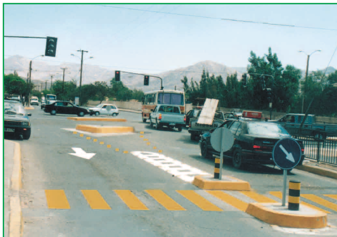
Islas medianas y demarcaciones canalizan movimientos. Se proveen vallas para desincentivar el cruce de peatones en lugares de mayor riesgo, e islas o habilitación de mediana, para que crucen en dos etapas
