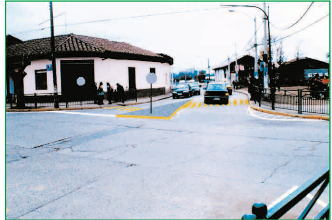
Vallas canalizan los movimientos peatonales hacia lugares más seguros
