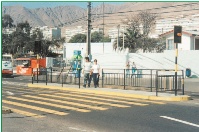
Isa mediana asiste el cruce de peatones en dos etapas. Balizas hacen el cruce más visibles para conductores
