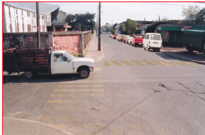
Visibilidad deficiente, obstaculizada por postes, para vehículos de la vía menor. Faltan brechas seguras debido a velocidad en vía principal
