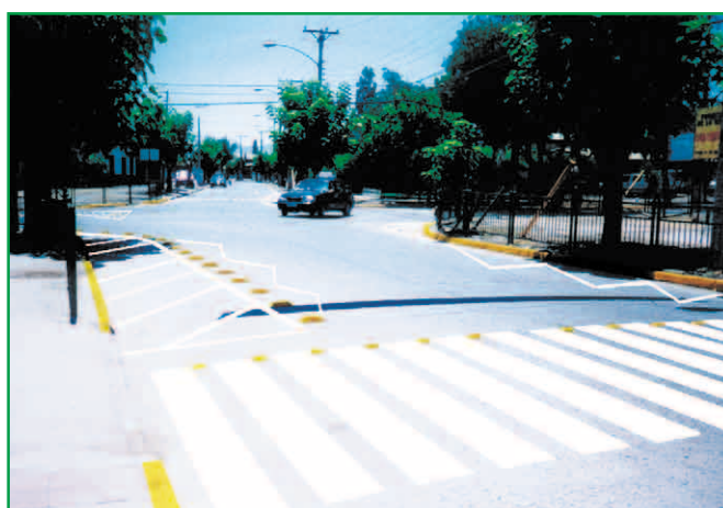
Extensión fantasma de acera, parte de mejorar visibilidad, calma la velocidad en la vía principal
