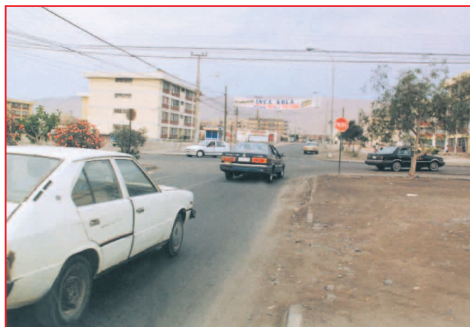
En esta intersección existen conflictos por múltiples virajes hacia la izquierda y por cambios de sentidos de las vías una vez pasada la intersección. No existen facilidades seguras para el cruce de peatones
