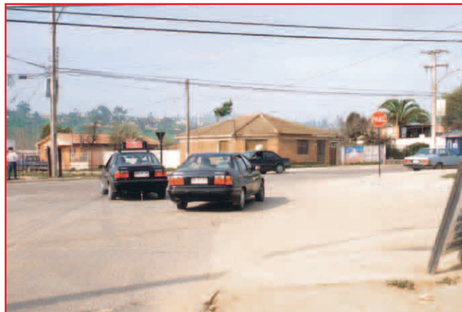
En esta intersección existen muchos conflictos entre vehículos que salen y vehículos que entran a la vía, debido a la falta de canalización de los diferentes movimientos
