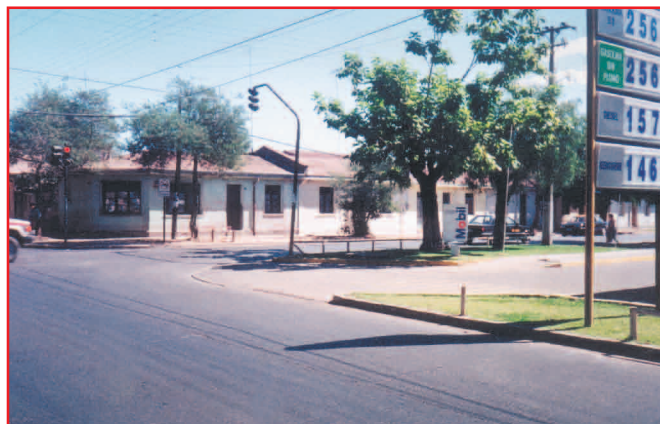
Acceso a bencinera justo en la esquina genera conflictos entre vehículos y situaciones de gran riesgo para peatones, puesto que se han eliminado las aceras a favor del acceso
