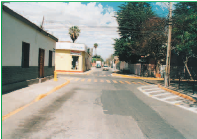
Extensiones de acera mejoran visibilidad de vehículos que emergen desde vía menor. Se genera una "curva fantasma" la cual calma la velocidad de los vehículos en la vía mayor, generando brechas más seguras. Mejoran condiciones para los peatones.
