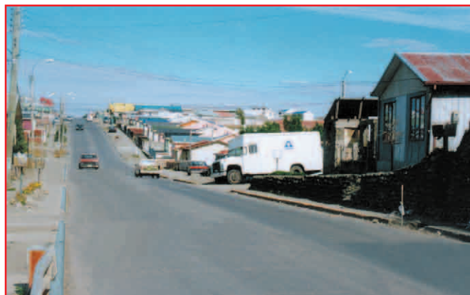
Exceso de velocidad en esta vía con pendiente en ambos sentidos, y falta de notoriedad de la intersección que está justo en la cima (vía menor es de tierra pero muy usada)
