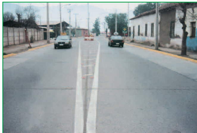
Mediana fantasma e isla mediana sólida en la curva frente a intersección, mejoran notoriedad de la intersección, calman las velocidades y protegen a peatones que cruzan
