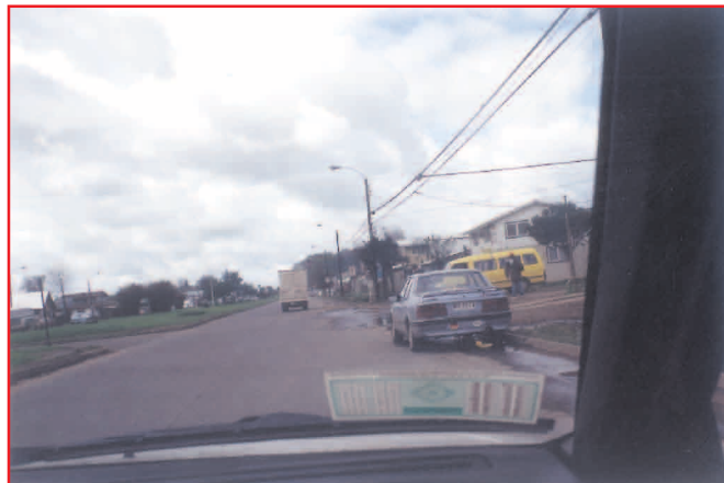
Vía larga, ancha y recta incentiva la velocidad. Visibilidad deficiente para vehículos de vía menor debido a vehículos que se detienen y estacionan en vía principal. Faltan condiciones seguras para cruce de peatones
