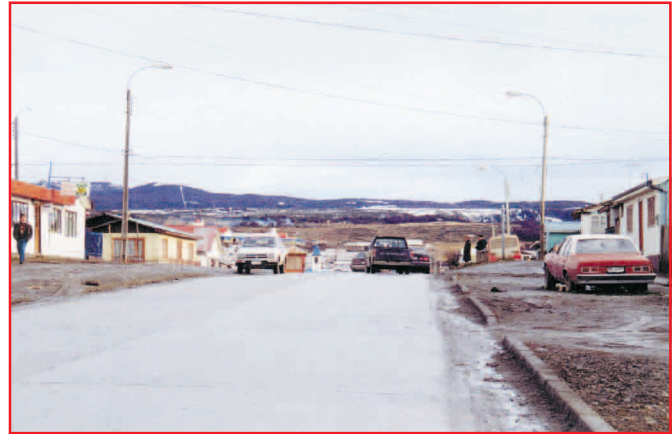
En la cima de esta vía existe una intersección la cual no es percibida por los conductores. Intersección carece de "notoriedad"
