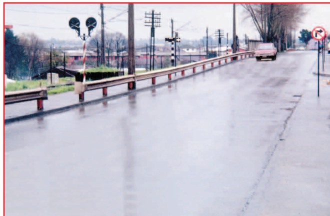
Tramo largo y recto incentiva la velocidad. No se percibe la intersección "T". Vehículos de vía menor no tienen brechas seguras
