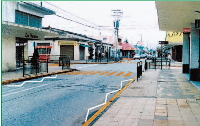
Vallas canalizan peatones hacia cruces retirados de las esquinas, para reducir conflictos entre vehículos que viran y peatones que cruzan
