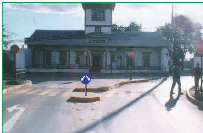
Isla canaliza los movimientos y provee mayor protección para los vehículos que esperan. Peatones pueden cruzar en dos etapas
