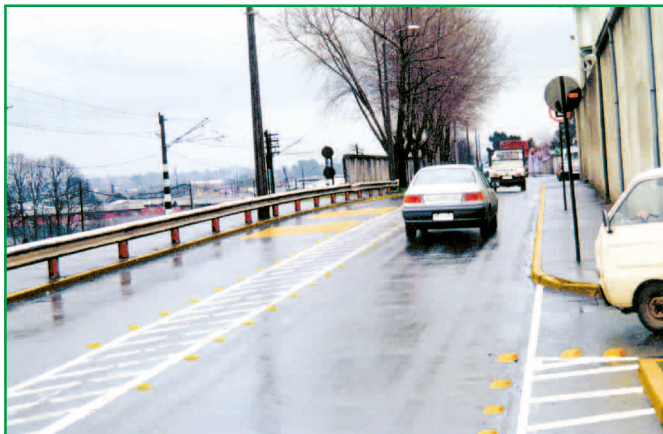
Bandas alertadoras y mediana fantasma que angosta la vía, calman las velocidades. Peatones pueden cruzar en dos etapas. Vehículos de vía menor ahora pueden tener brechas más seguras
