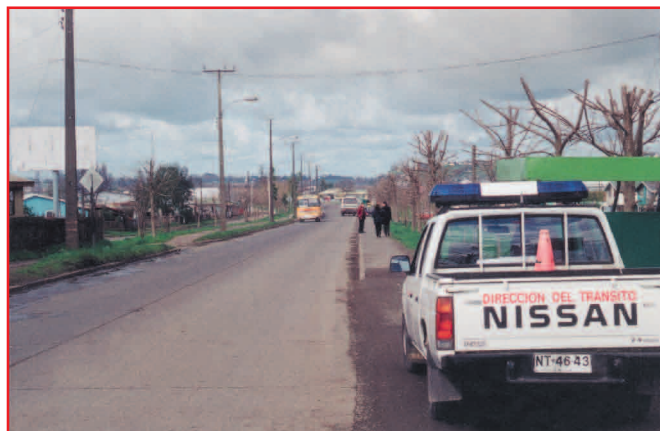
En esta vía de entrada a la ciudad, los conductores transitan a exceso de velocidad pues no perciben el cambio en las condiciones del entorno. No existen condiciones seguras para el cruce de peatones
