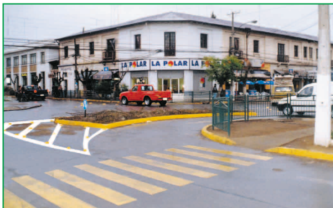
Con islas se canalizan los diferentes movimientos vehiculares. Peatones canalizados por vallas
