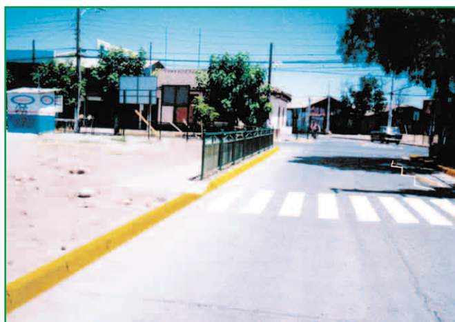
Se habilita la acera (izquierda) para el cruce y circuito peatonal.
