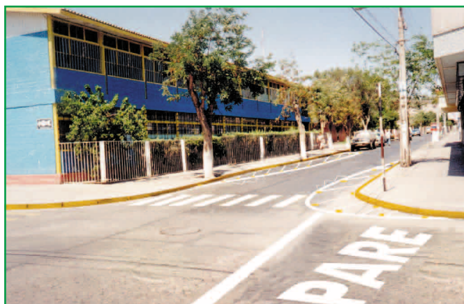
Extensiones fantasma de aceras permiten que vehículos se asomen más adelante. También calma la velocidad de vehículos en vía principal (se crea como una curva falsa)
