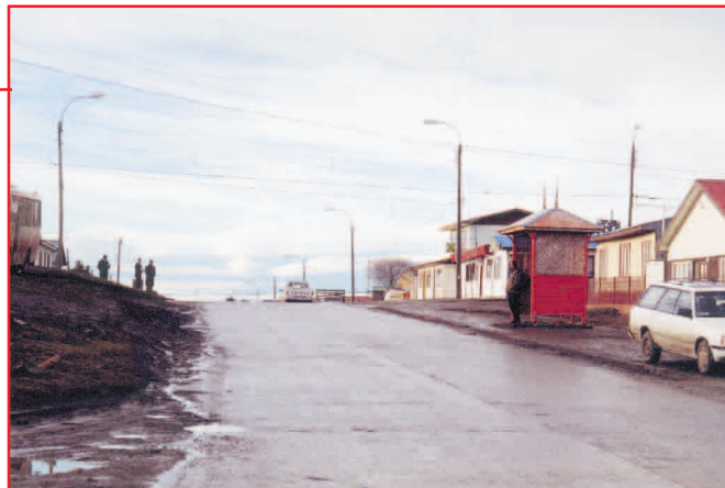
Otra vista de la intersección sin notoriedad. Peatones y vehículos tienen muy mala visibilidad uno del otro
