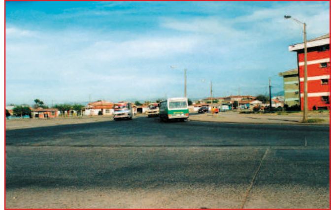
Extensa área de intersección de dos vías de doble sentido en donde los conductores pierden referencia de las prioridades. Múltiples virajes hacia la izquierda
