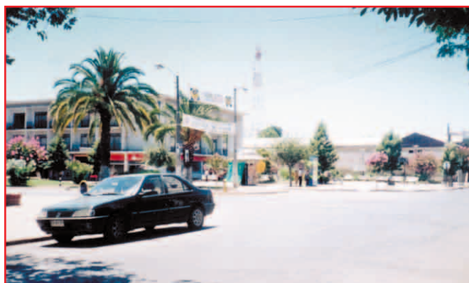
Otra vista de intersección con falta de canalización de movimientos.
