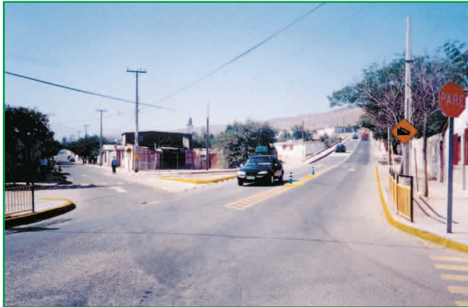
Bandas alertadoras y mediana fantasma calman las velocidades. Todos los movimientos son canalizados. El viraje a la izquierda se canaliza a través de una oreja
