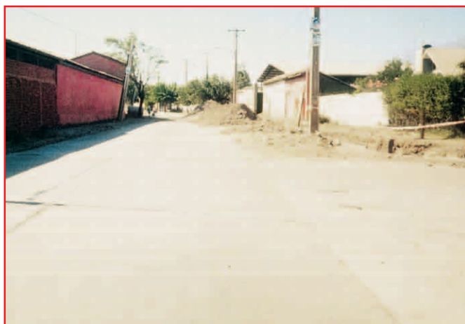
Vista a mayor distancia de la intersección en esta vía de entrada a la ciudad en donde los vehículos transitan a exceso de velocidad
