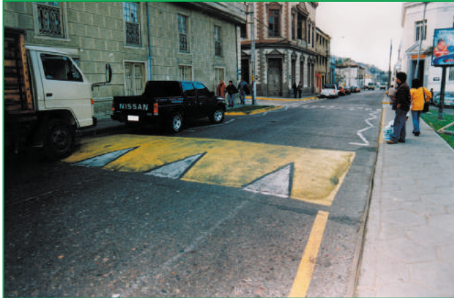
Lomos de toro calman la velocidad . Extensión de acera impide que vehículos se estacionen en la esquina lo cual mejora visibilidad y seguridad vehicular y peatonal.
