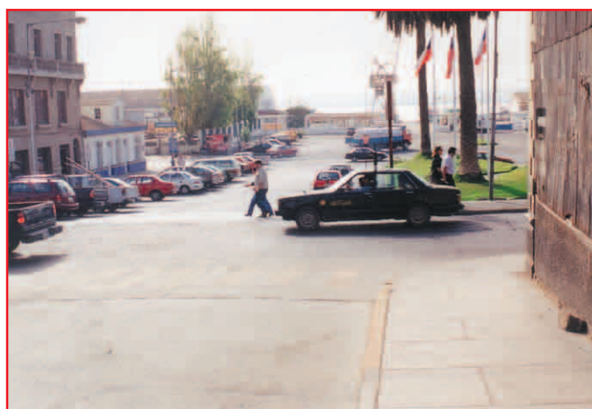
En este tramo de vía no está definido claramente cual es el área de estacionamiento y cual es de calzada. Incentiva velocidad al percibirse como una vía ancha en pendiente. La franja correspondiente a la acera ha desaparecido a favor del estacionamiento, el cual además genera riesgos debido a su posición perpendicular.
