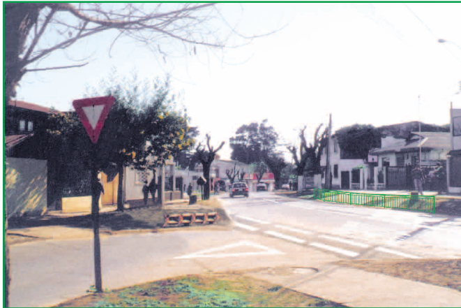
Lomos de toro para calmar velocidades y desincentivar tráfico de paso. Extensión de acera mejora visibilidad desde vía menor. Peatones son canalizados a cruce con mejor visibilidad
