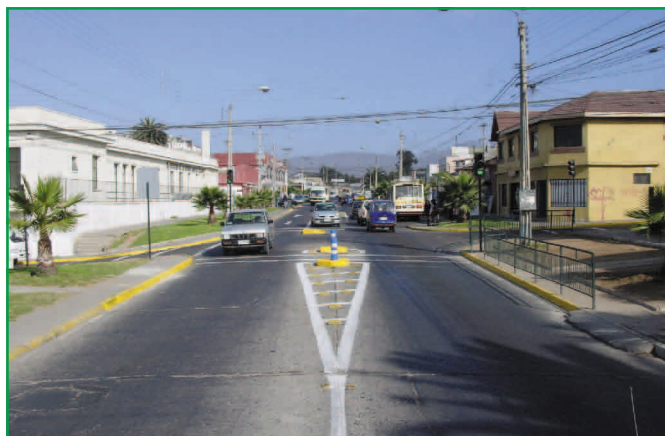
Mediana fantasma e islas peatonales permiten cruce de peatones en dos etapas, además de calmar las velocidades al angostar la vía.
