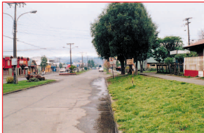
Intersección con conflictos por múltiples virajes hacia la izquierda; faltan brechas seguras para la vía menor y facilidades seguras para el cruce de peatones
