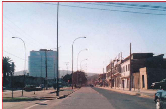
La mediana de esta vía es intersectada por tramos de doble sentido, en los cuales se generan conflictos entre los vehículos que esperan y aquellos que viran desde vía principal, y de éstos con peatones, aparte de los conflictos por virajes en la intersección
