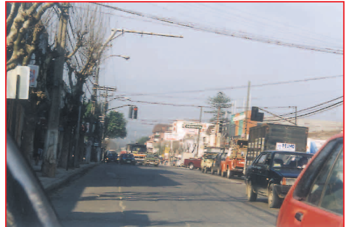
Falta de demarcaciones incentiva entrecruzamientos vehiculares
