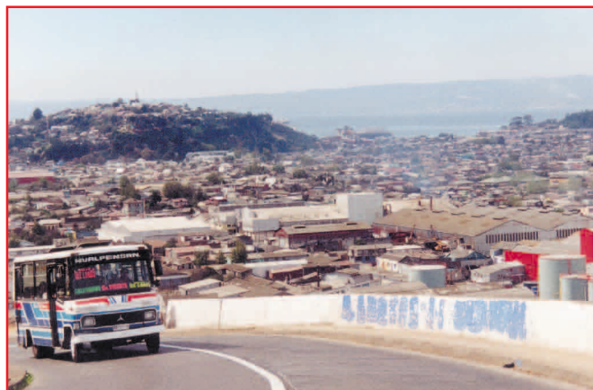
Faltan elementos que permitan al conductor mejor percepción de la delineación de la vía
