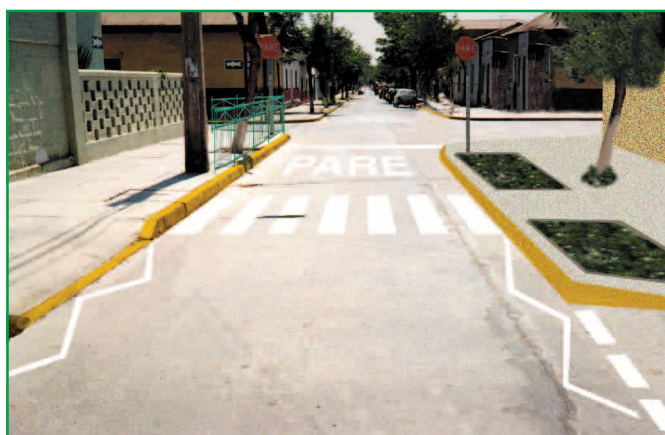
Extensión de acera angosta la vía y calma la velocidad. También mejora la notoriedad de la intersección con la vía menor y permite que peatones crucen en un espacio despejado de vehículos estacionados
