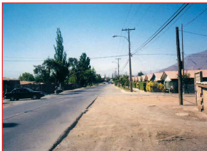
Este es el inicio de la vía de entrada a la ciudad. La berma que ha sido pavimentada para ser usada como franja de estacionamiento crea la falsa sensación de que la vía se ensancha lo cual incentiva la velocidad.
