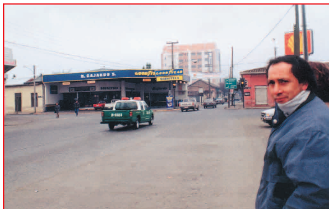
Esta intersección semaforizada es muy confusa tanto para conductores como peatones, puesto que tienen diferentes alineaciones y sentidos, se podría decir que operacionalmente son cuatro las vías que se intersectan. Existen además, accesos en o muy cerca de las esquinas
