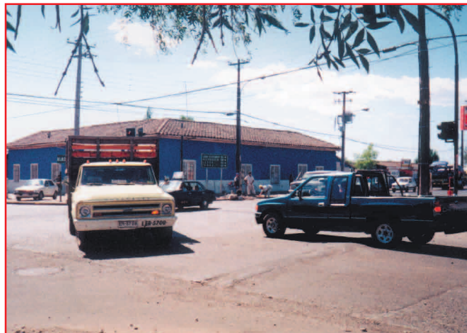
En esta intersección no existen facilidades claras para el cruce de peatones. Es muy confuso, especialmente por los múltiples virajes vehiculares.
