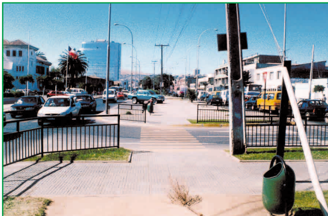
Se dejan todos los tramos que intersectan la mediana de un sentido solamente (alternando los sentidos), lo cual simplifica el tránsito para conductores. Se desplazan cruces peatonales desde las esquinas y se proveen vallas canalizadoras
