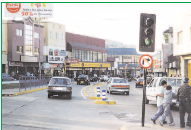
Se provee bandejón para segregar los flujos de las dos vía que convergen. Islas asisten el cruce de peatones en dos etapas.
