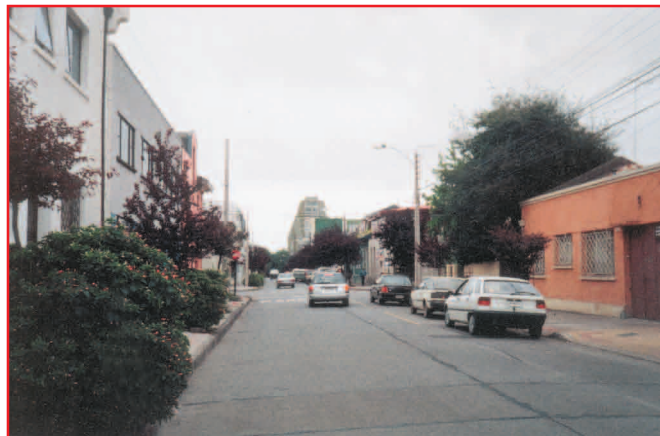
El ancho de la vía incentiva la velocidad en el acercamiento a la intersección. Los vehículos estacionados contribuyen a que disminuya la notoriedad de la intersección
