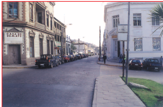
Típica vía larga y recta que incentiva la velocidad y en la cual vehículos que se estacionan en un costado hasta la esquina obstaculizando la visibilidad. Peatones cruzan entre vehículos estacionados.
