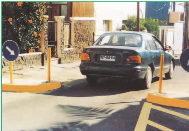
Restrictor de ancho elimina el paso de los vehículos de carga, desincentiva el tráfico de paso y calma velocidades, creando un entorno más seguro para los residentes
