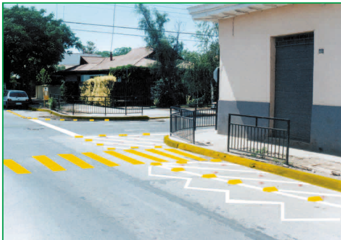
Se extienden las aceras en forma fantasma, lo cual permite que los vehículos puedan asomarse más adelante con mayor seguridad y tener mejor visibilidad.
