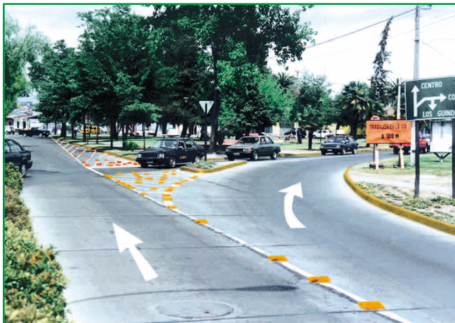
En la vía principal se deja una pista exclusiva para virar, para lo cual se cierra la pista extendiendo la isla de tráfico. Ahora los vehículos de la vía menor pueden asomarse con mayor seguridad
