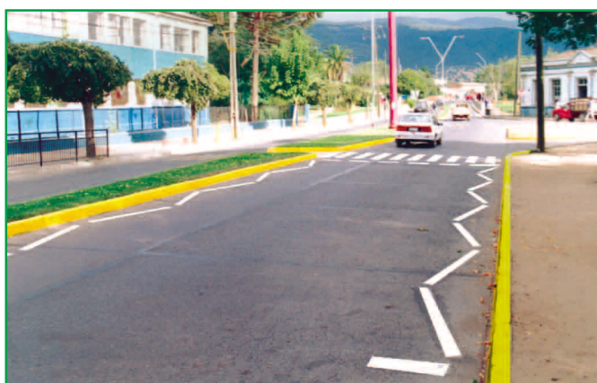
Se habilita paso en la mediana y cruce cebra. Vallas canalizan peatones.
