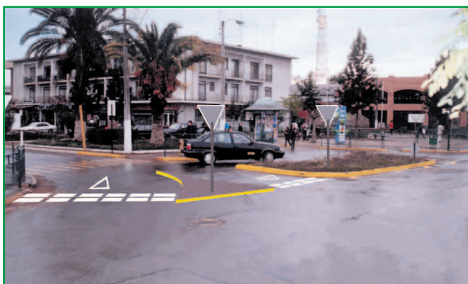
Intersección con movimientos canalizados
