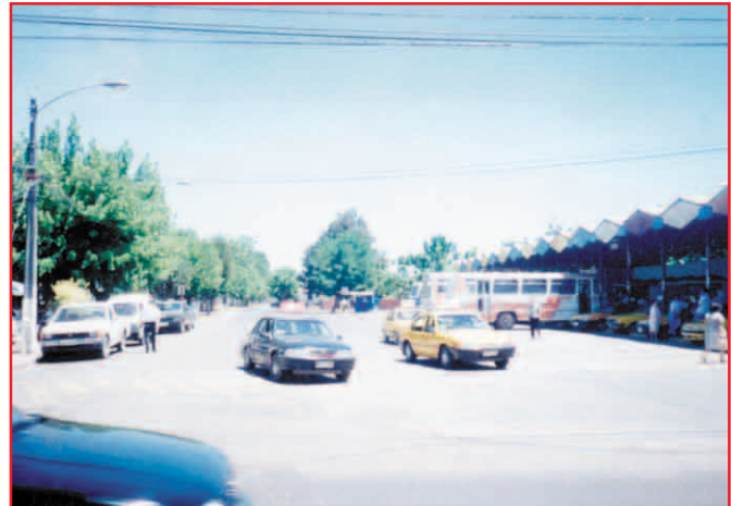
En esta intersección y tramo se confunde el área del terminal (derecha) con la de la vía (izquierda) quedando los peatones totalmente vulnerables. Varios de estos casos se repiten en Chile al designar espacio para terminales
