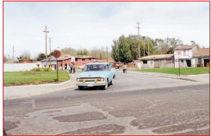
Otra intersección de la vía principal, sin canalización de movimientos ni facilidades peatonales. En vía menor se producen entrecruzamientos por parada de buses (izquierda)
