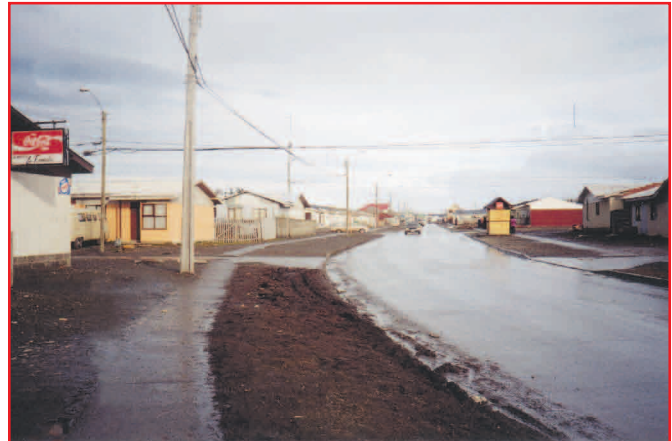
Esta vía precede la intersección. El exceso de velocidad y la curva no permiten que la intersección se perciba con la debida antelación para que conductores cautelen la velocidad
