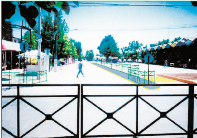
Se recupera espacio original de la calzada y acera para peatones. Se define claramente el acceso y salida de terminal
