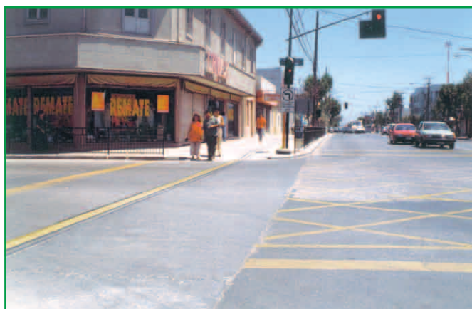
Demarcaciones no bloquear y vallas peatonales mejoran comportamiento de los conductores. Estas últimas desincentivan estacionamiento hasta las esquinas
