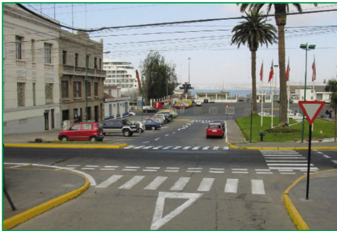
Se definen los espacios de estacionamiento y calzada, recuperando la franja de la acera para peatones. Esto ayuda además a calmar las velocidades en el tramo. Nótese (plano) que el estacionamiento había sido propuesto en forma paralela para mayor seguridad.
