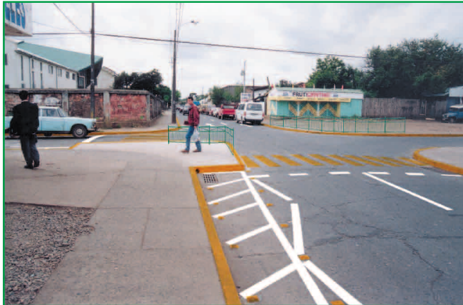
Extensiones de acera mejoran visibilidad; también contribuyen a calmar velocidades en vía principal. Se mejoran cruces peatonales
