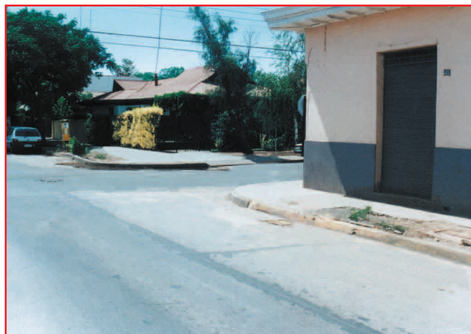
La vía menor tiene mala visibilidad debido a falta de ochavo de la la edificación, existencia de árboles y vehículos estacionados.
