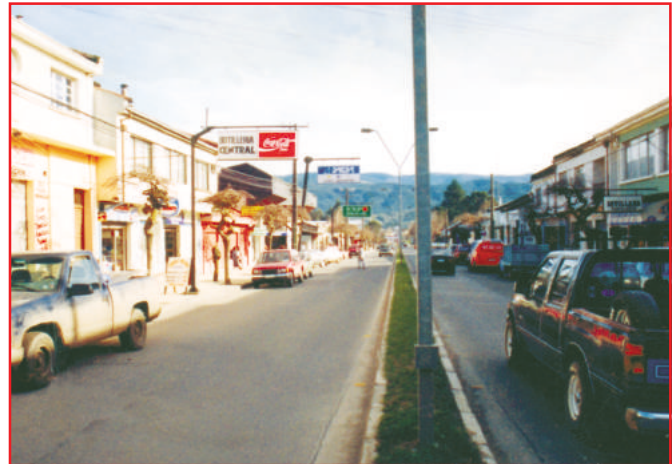
Peatones tienden a cruzar en cualquier lugar a lo largo de este eje puesto que la mediana, que es muy angosta, incentiva este tipo de movimiento
