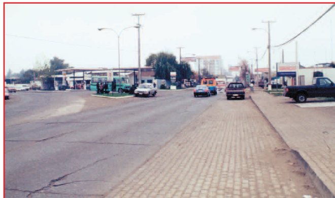
Esta vía de entrada a la ciudad (derecha) es de doble sentido, con un alto porcentaje de vehículos de carga y pasajeros, uso de suelo comercial con múltiples accesos (virajes hacia izquierda), lo cual se traduce en múltiples conflictos entre vehículos y atropello de peatones
