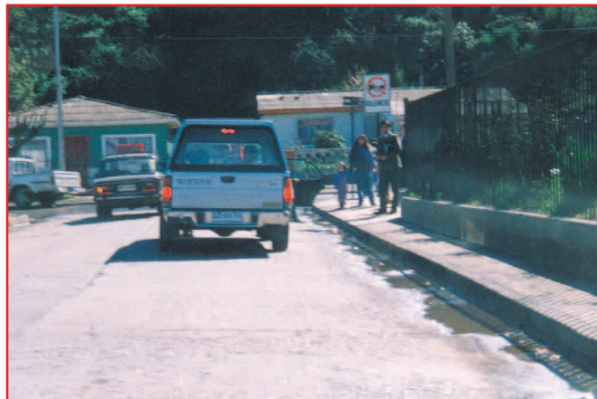
En esta vía existen múltiples conflictos, ya que es muy angosta para todas las funciones que cumple: tránsito en doble sentido, parada de locomoción colectiva, circulación de peatones (acera es muy angosta).
