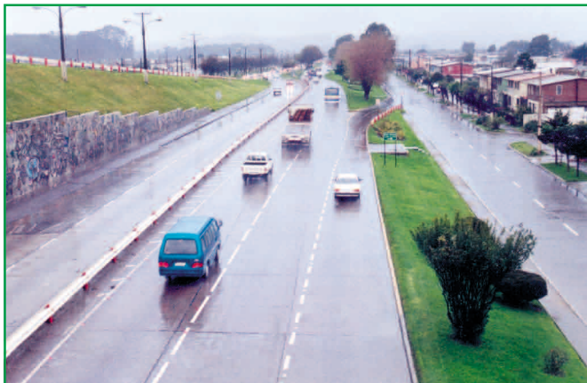
Con demarcaciones se definen pistas de circulación y se segrega la pista de aceleración/desaceleración. Nótese achurado al costado de la barrera para corregir alineación de la vía
