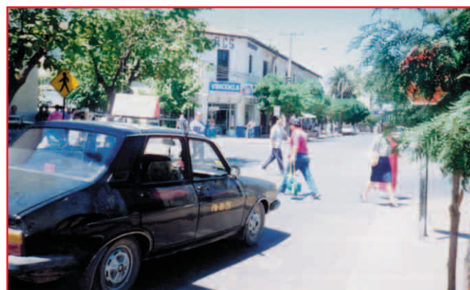
Otra vista de la intersección que muestra la falta de canalización vehicular y peatonal.
