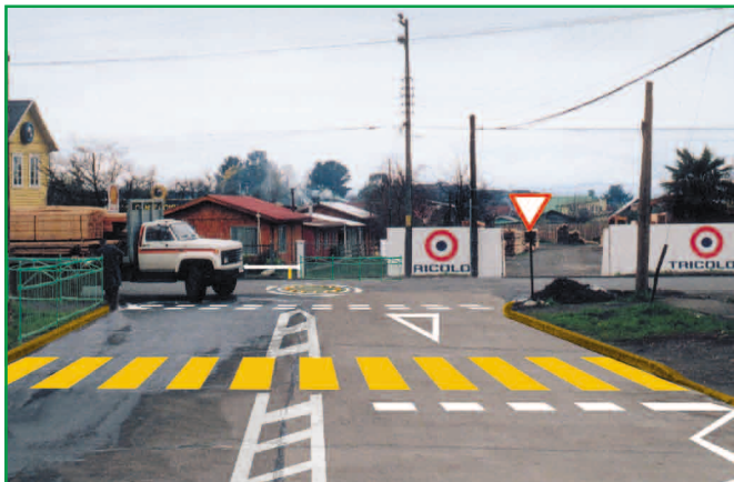
Mini-rotonda elimina conflictos por virajes hacia la izquierda, calma las velocidades en vía principal y permite brechas seguras. Nótese cruce peatonal desplazado desde la esquina
