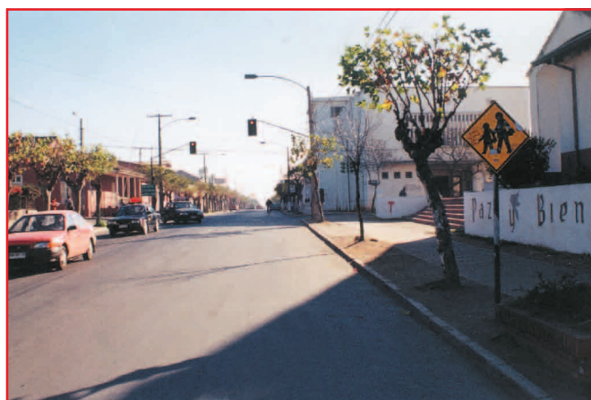
Vía cambia a un sentido pasada la intersección (semáforo) lo cual no es percibido claramente por los conductores ni tampoco por peatones.
