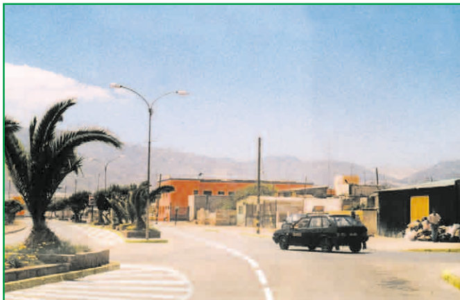
La mediana se ensancha (en forma fantasma) gradualmente a ambos lados, con lo cual se provee un espacio con mejor visibilidad para los vehículos que viran hacia la izquierda desde vía menor. También angosta la vía principal calmando la velocidad
